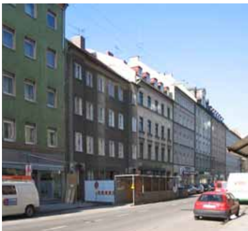
Bestand vor Aufstockung (Blick nach Westen)
