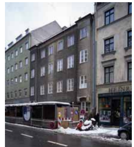
Bestand vor Aufstockung (Blick nach Osten)
