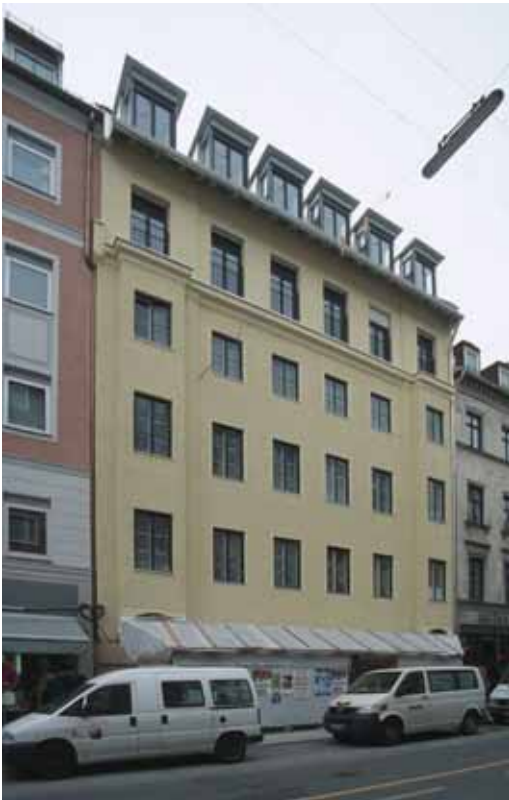
Ansicht Schellingstraße nach Aufstockung
