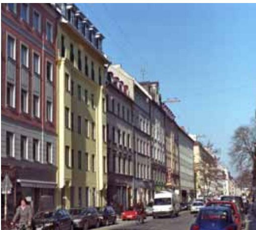
Straßenansicht nach erfolgter Aufstockung
