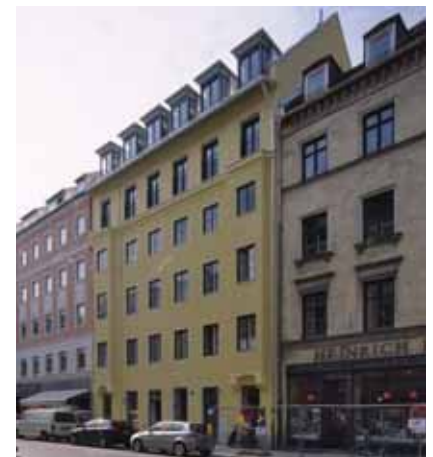
Straßenansicht nach erfolgter Aufstockung
